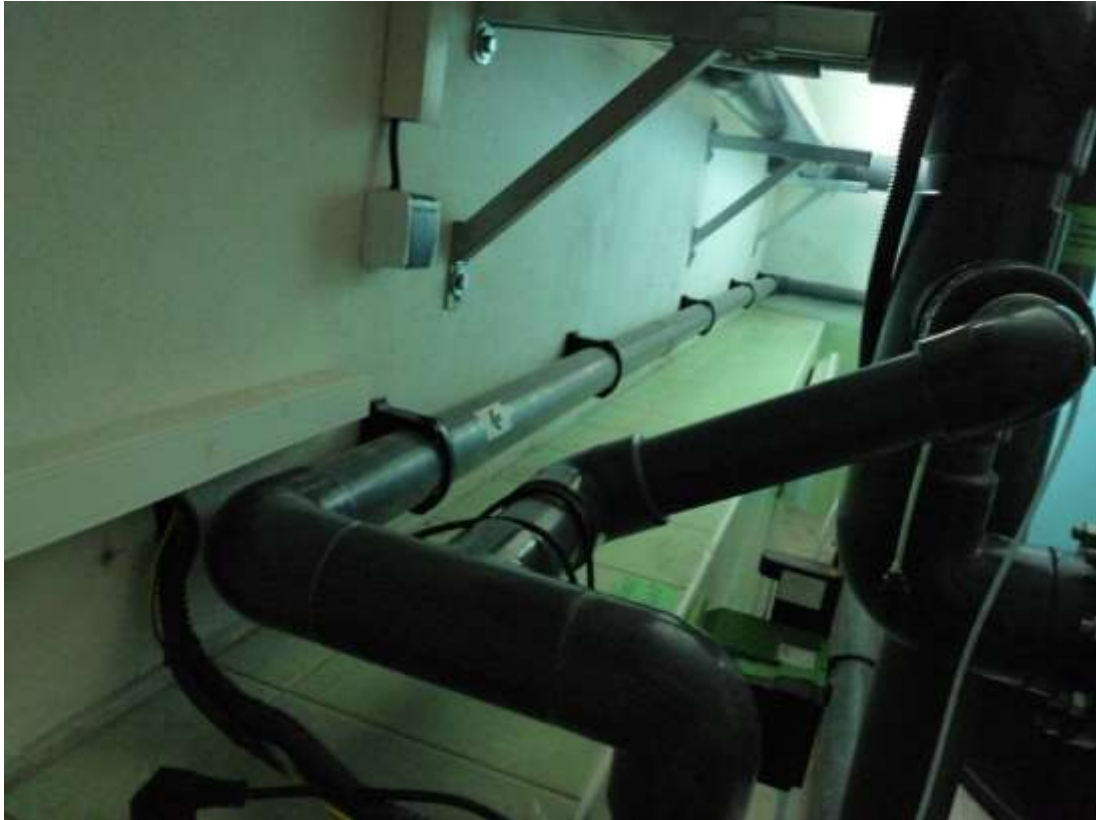
přepojení výměníku tepla na cirkulační okruh plaveckého bazénu
