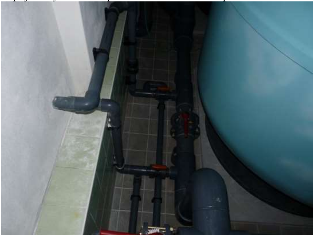
přepojení výměníku tepla na cirkulační okruh plaveckého bazénu
