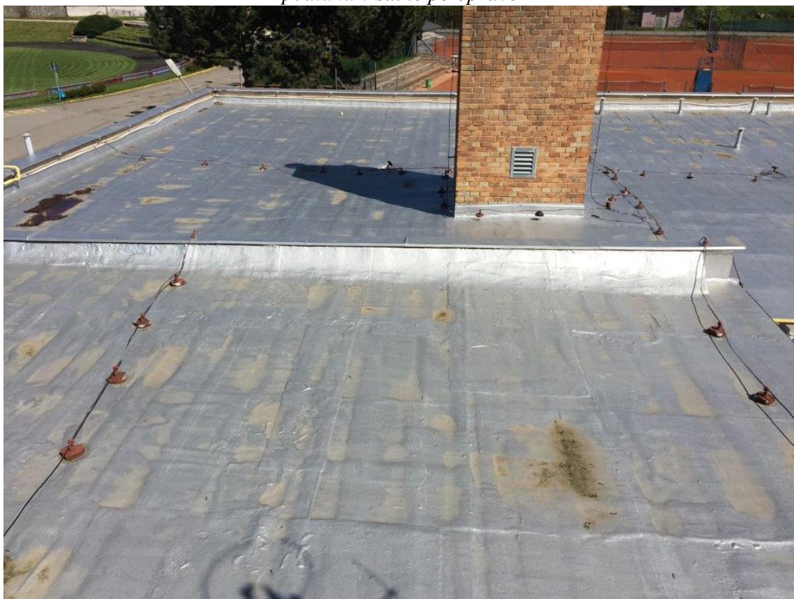
oprava střechy nad starou částí zimního stadionu
