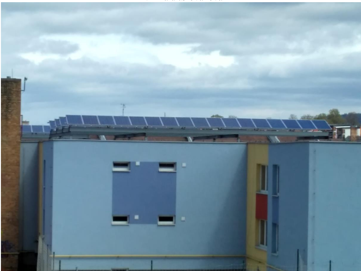
FVE na ulici Sušilova
