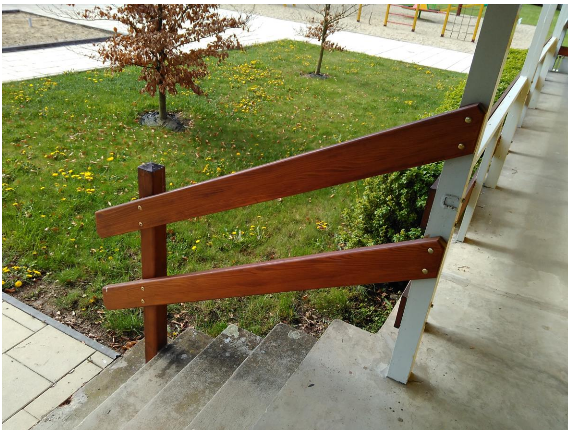
zábradlí na koupališti
