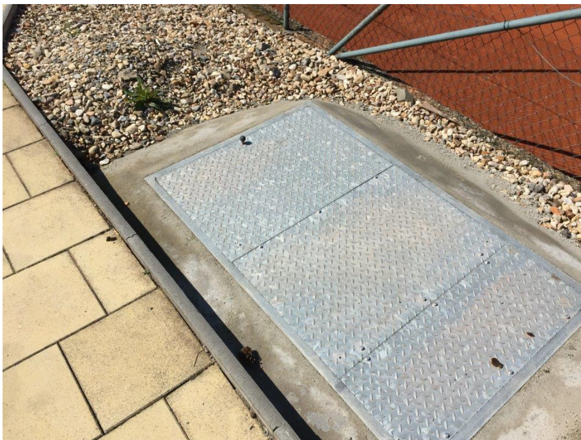
oprava vodovodní šachty
