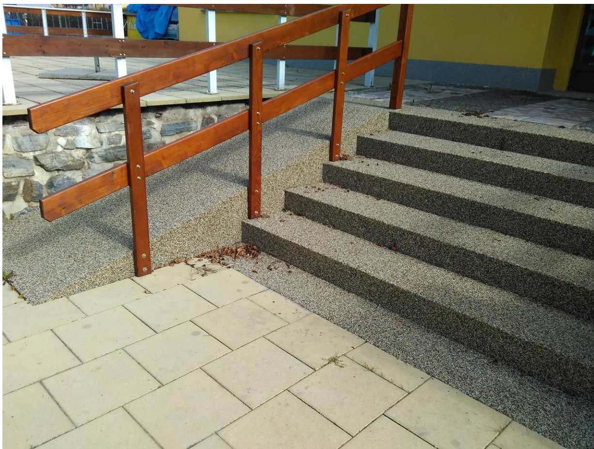
oprava schodiště za vstupní budovou
