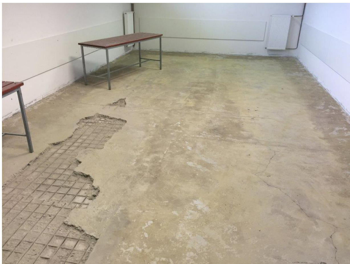
oprava podlahy v šatně
