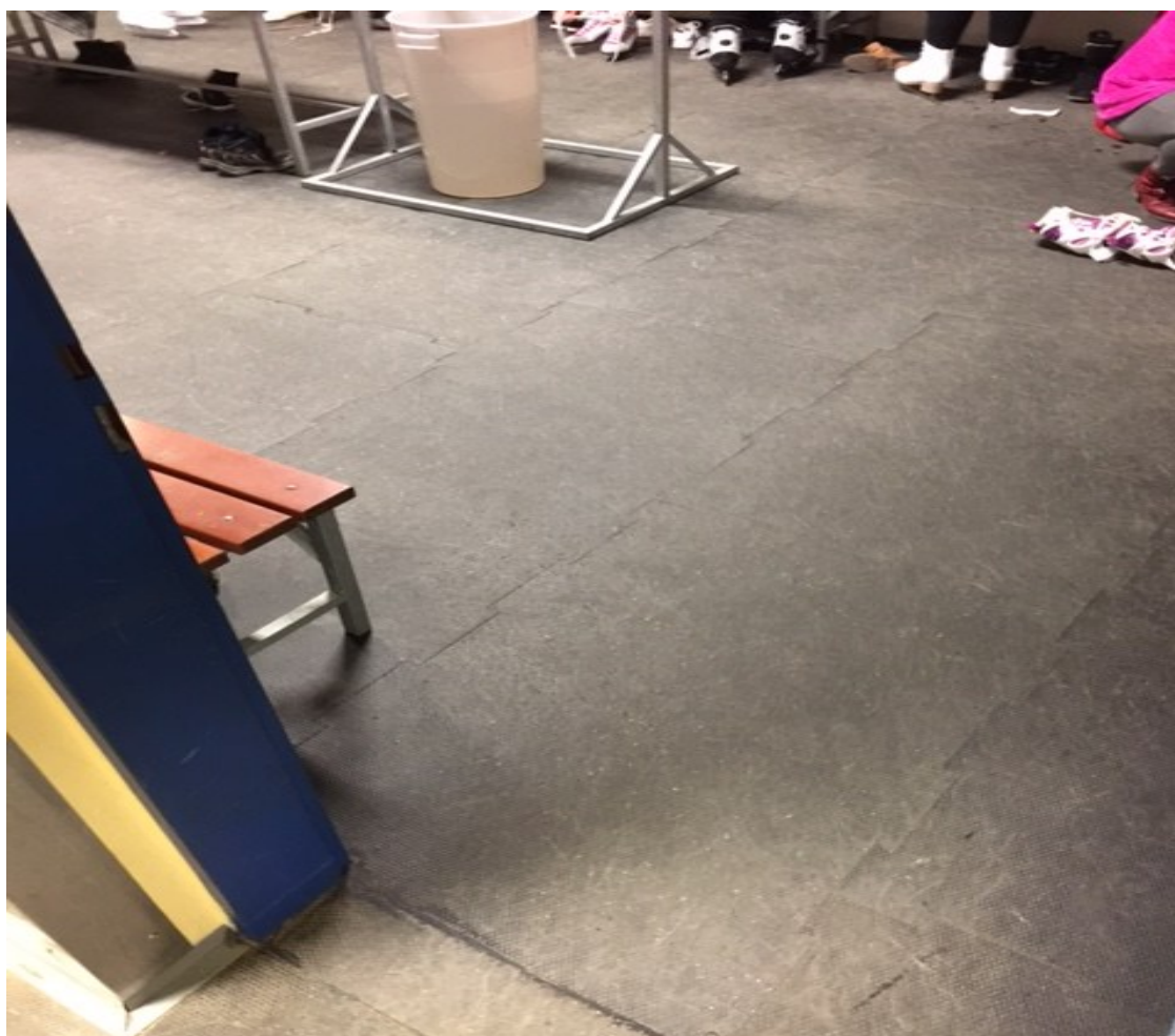
oprava podlahy v šatně
