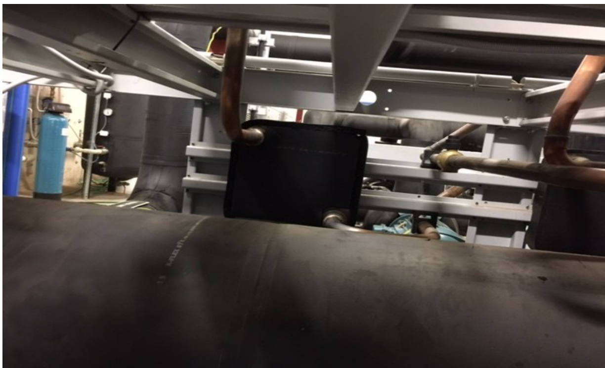
výměna výměníku u kompresoru
