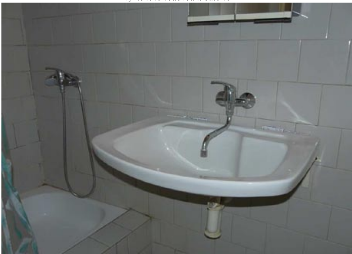
vyměněné vodovodní baterie
