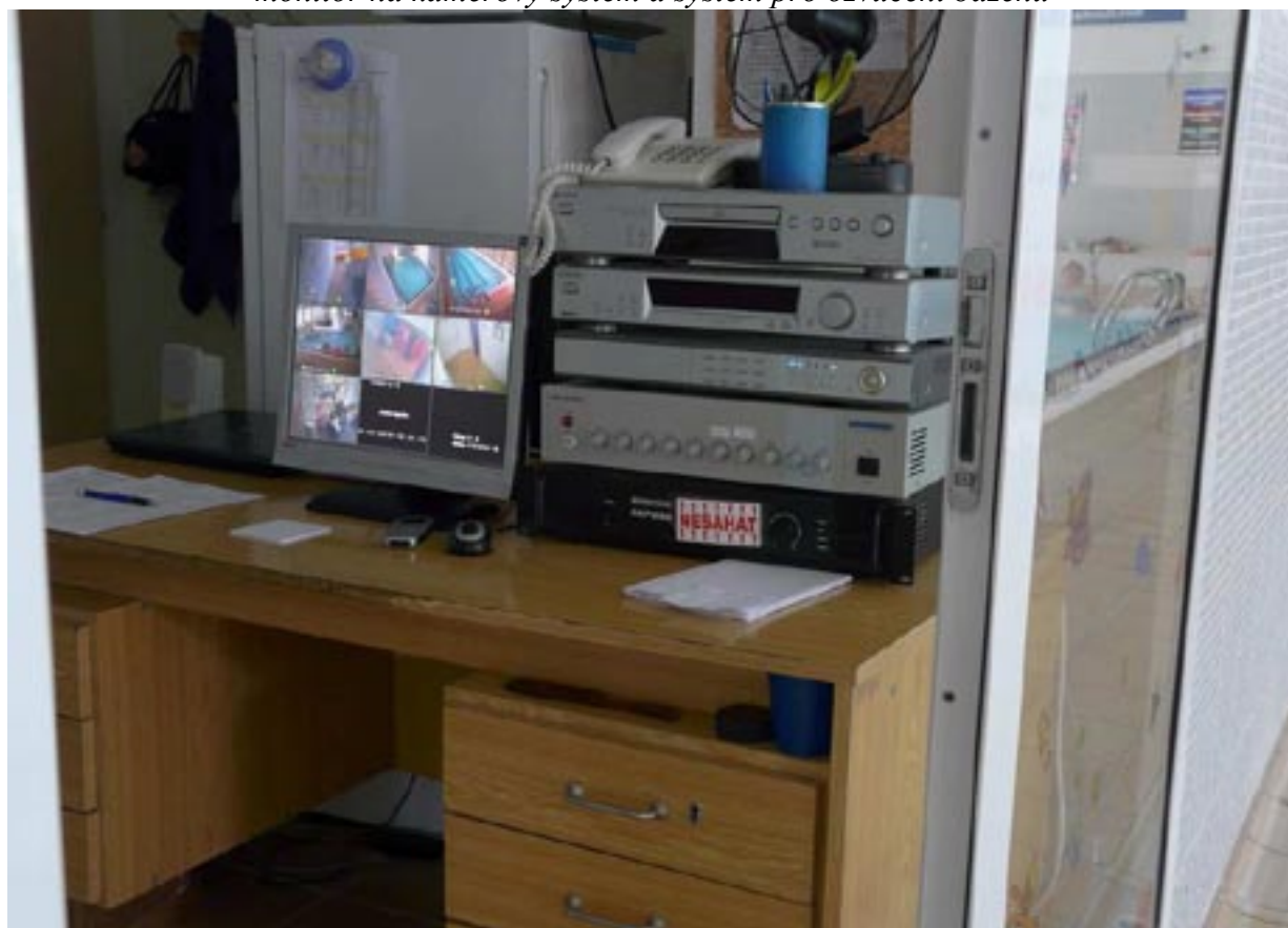
monitor na kamerový systém a systém pro ozvučení bazénů
