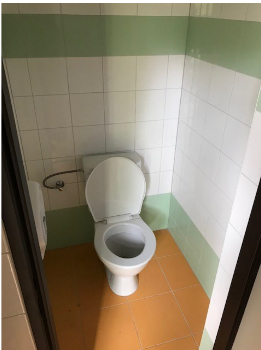
opravené dámské toalety pro veřejnost
