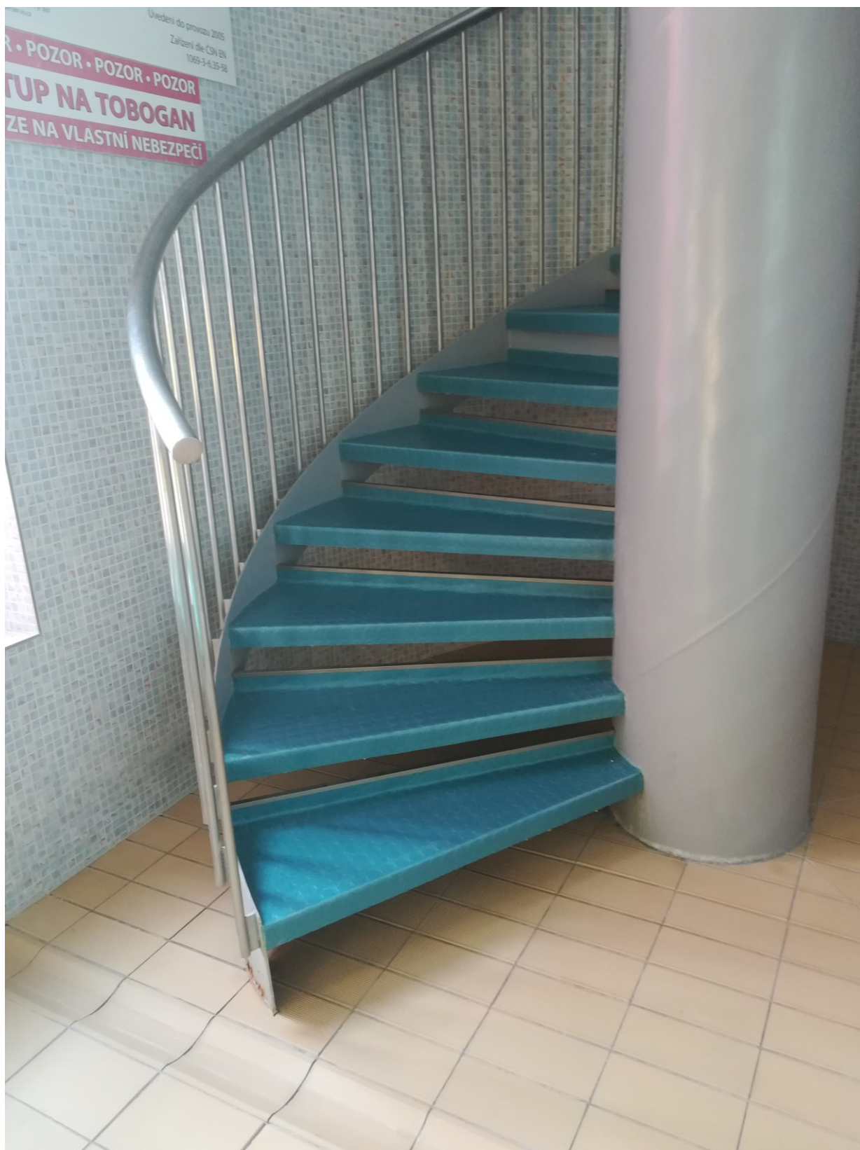
opravené schodiště na tobogán
