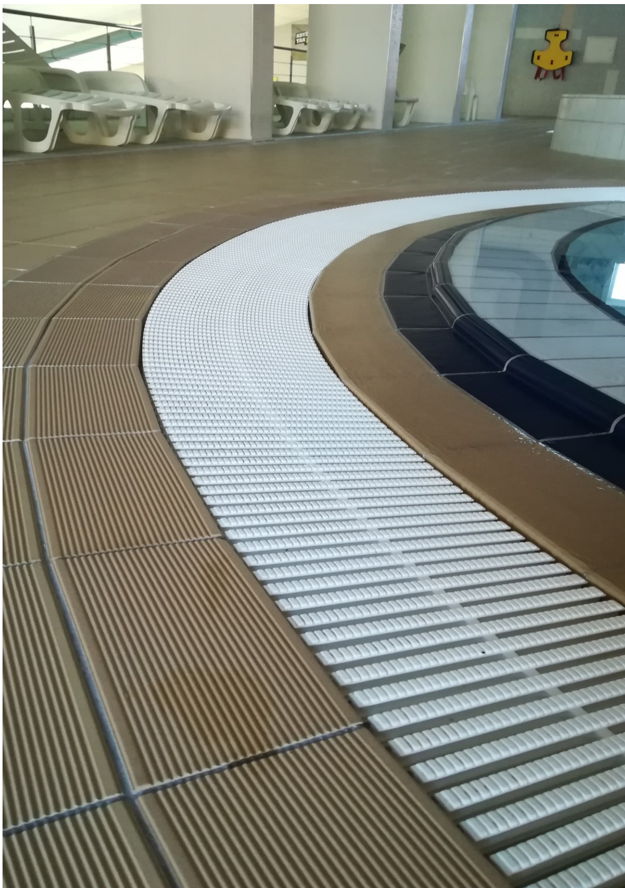
vyměněné přelivné žlábký
