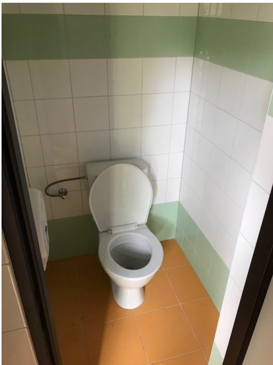
opravené dámské toalety pro veřejnost
