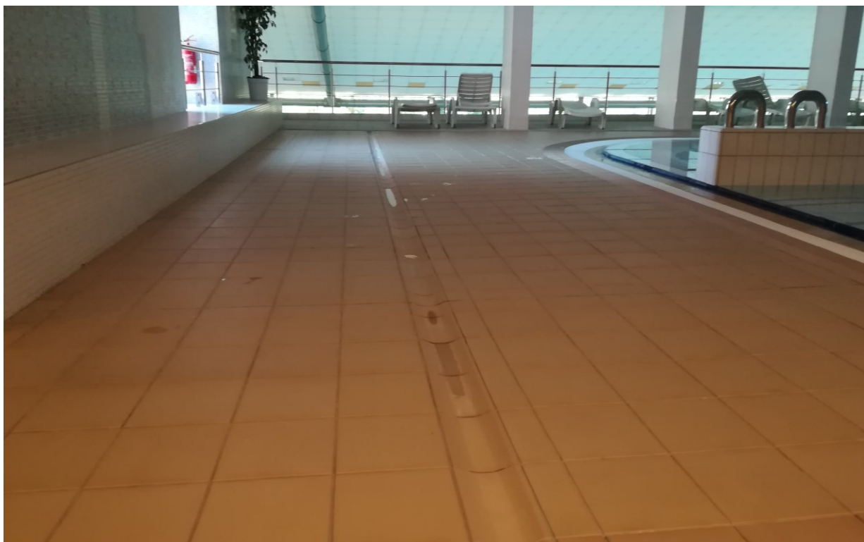
protiskluzový nátěr na rekreačním bazénu
