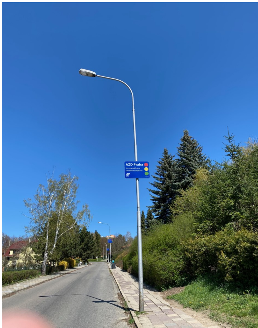
sloup veřejného osvětlení
