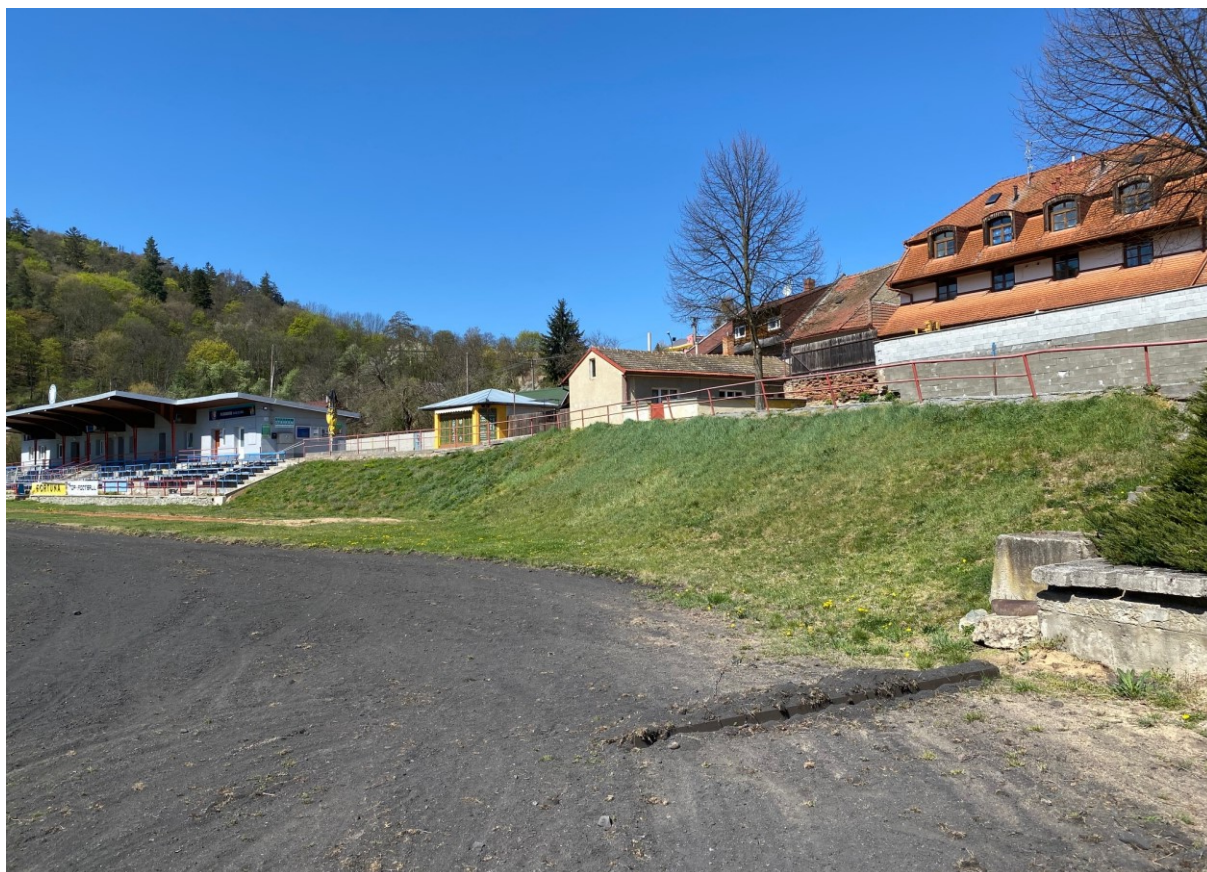
úprava svahu po pravé straně hlavní tribuny
