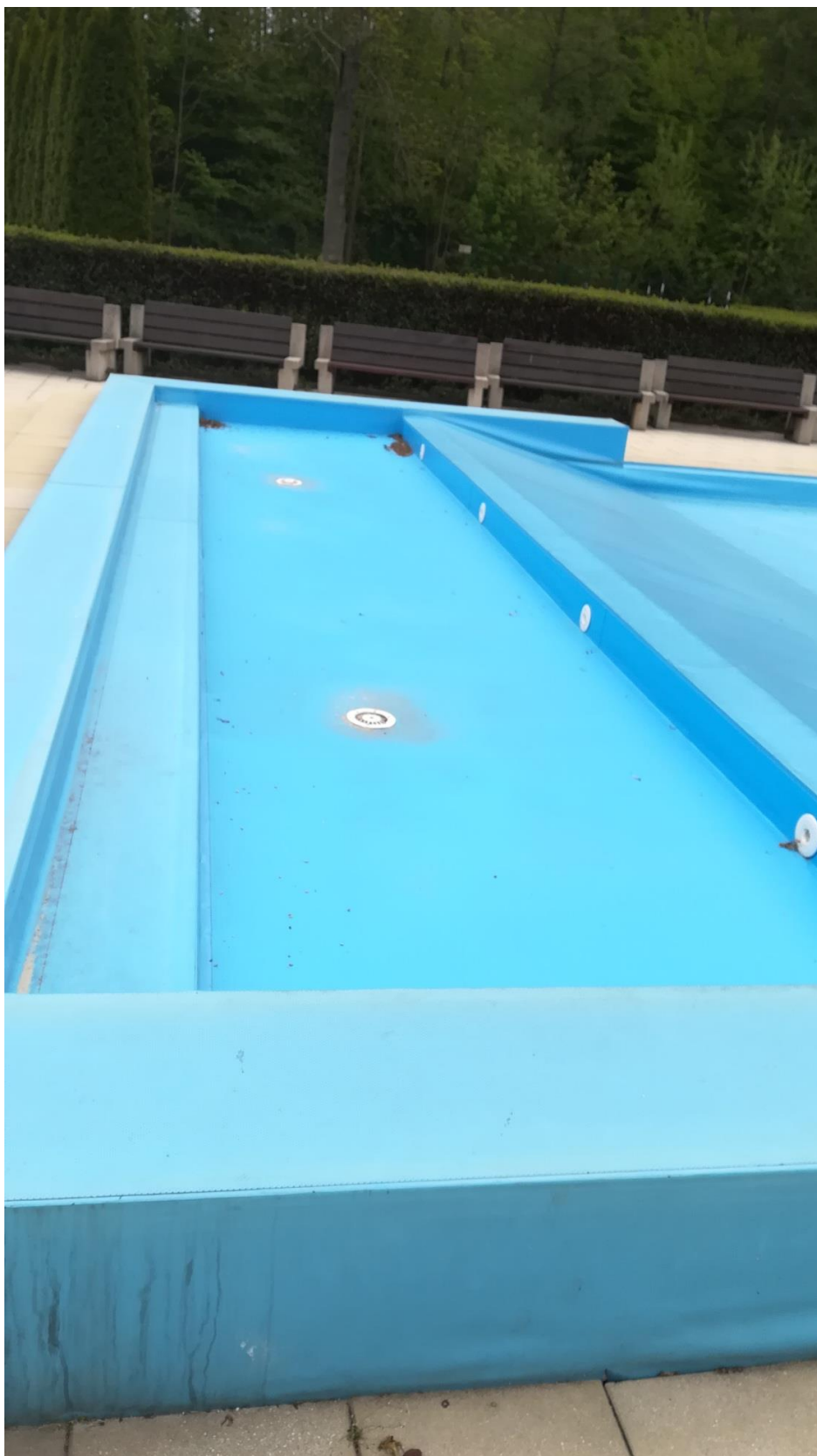
brouzdaliště po opravě
