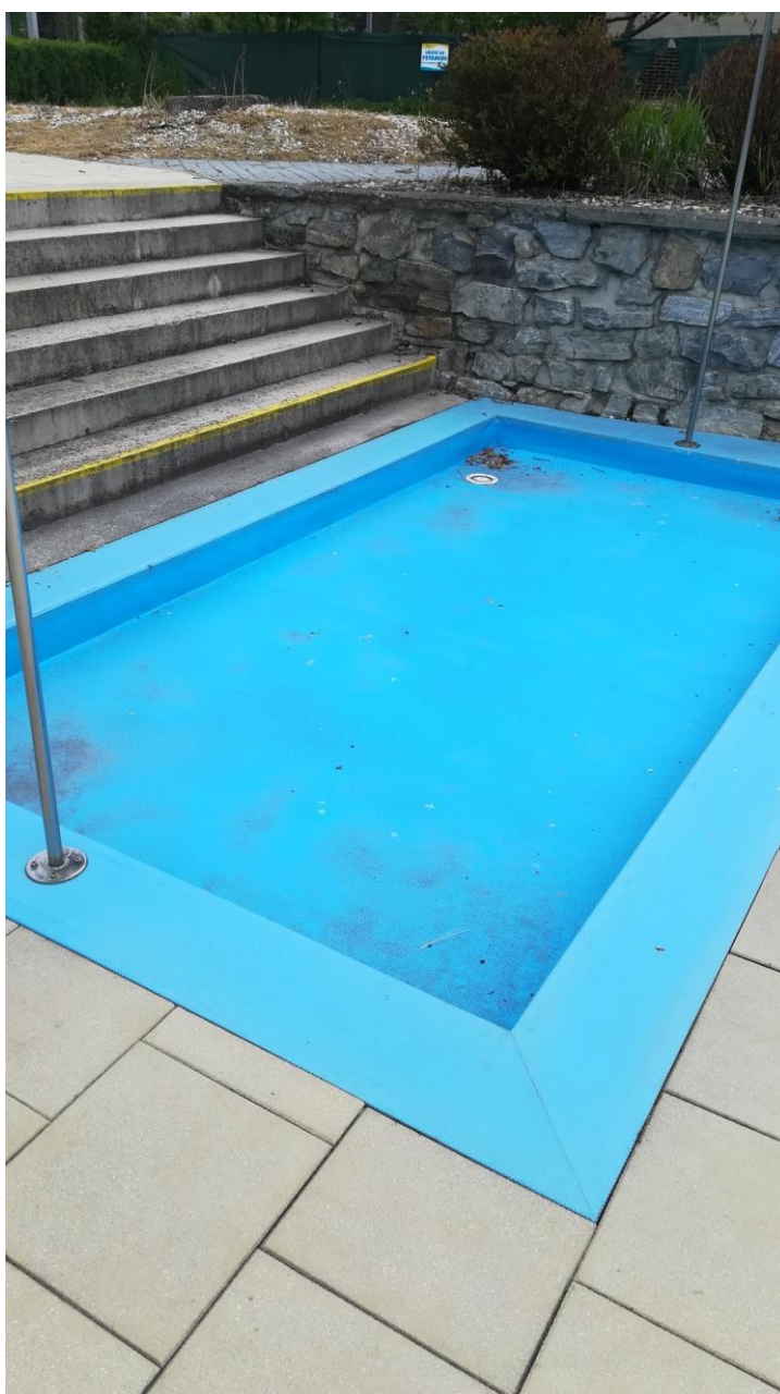
brodítko po opravě
